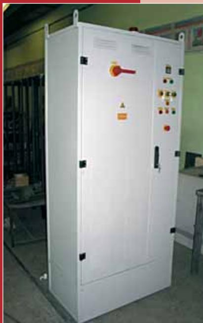
Блок управления с таймером
