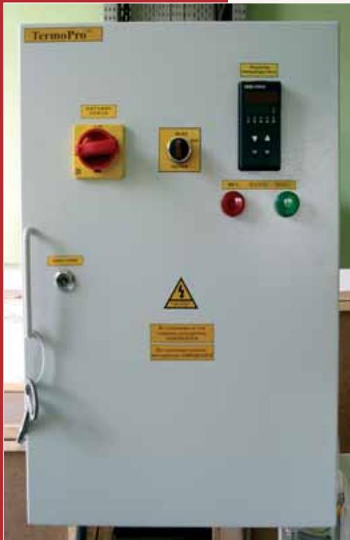
Блок управления с таймером
